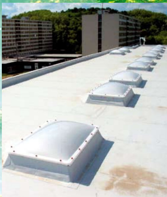
Obr. 1 – realizace pevných světlíků
